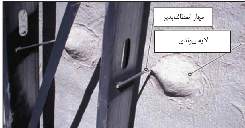
شکل ۶-۳۸ - لایه پیوندی و مهارهای انعطاف‌پذیر
