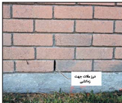
شکل ۵-۱۵- خالی گذاشتن درز ملات جهت زه‌کشی
