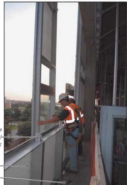
وصله ها در قطعه زیرین، این وصله ها جهت توسعه نما و نیز جابجا کردن آنها کاربرد دارند. قطعاتی که نصب شده اند بست های بار ثقلی
