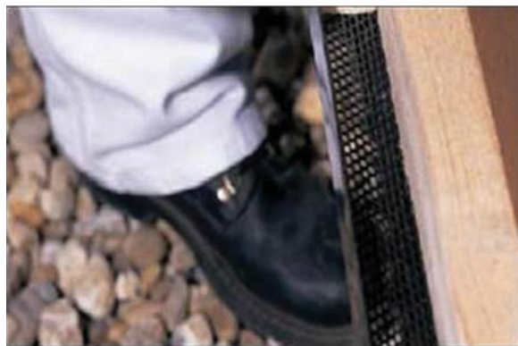
شکل ۶-۶۱- اجرای شبکه توری زیر دیوار
