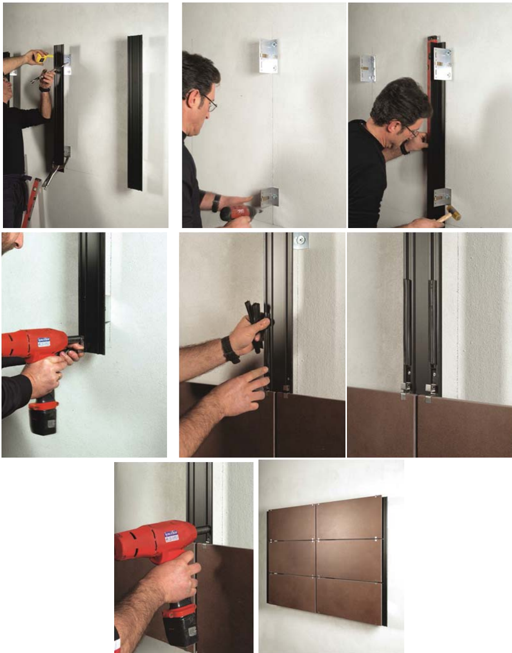
شکل ۷-۲۴- مراحل نصب سیستم نصب نمایان
