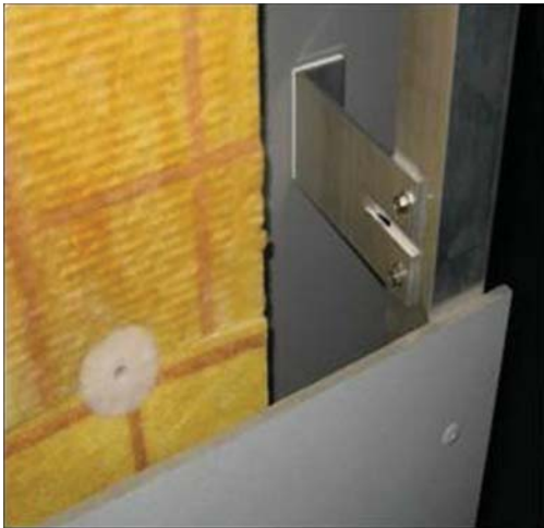
شکل ۶-۴۵- نمونه‌های زیرقاب ساخته‌شده با قطعات آلومینیومی
