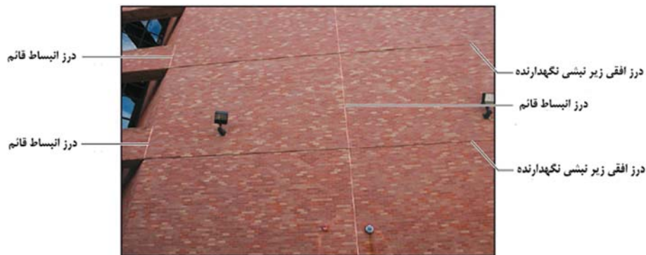
شکل ۵-۱۹- درز انبساطی پیوسته در نمای آجری
