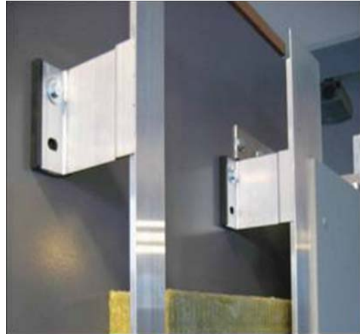
شکل ۶-۴۵- نمونه‌های زیرقاب ساخته‌شده با قطعات آلومینیومی
