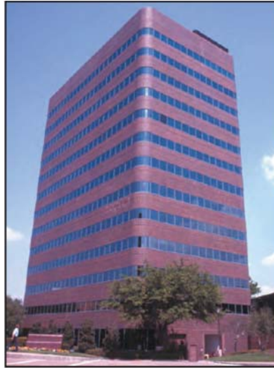
شکل ۵-۲۸- ساختمانی با نما آجری و پنجره‌های پیوسته
