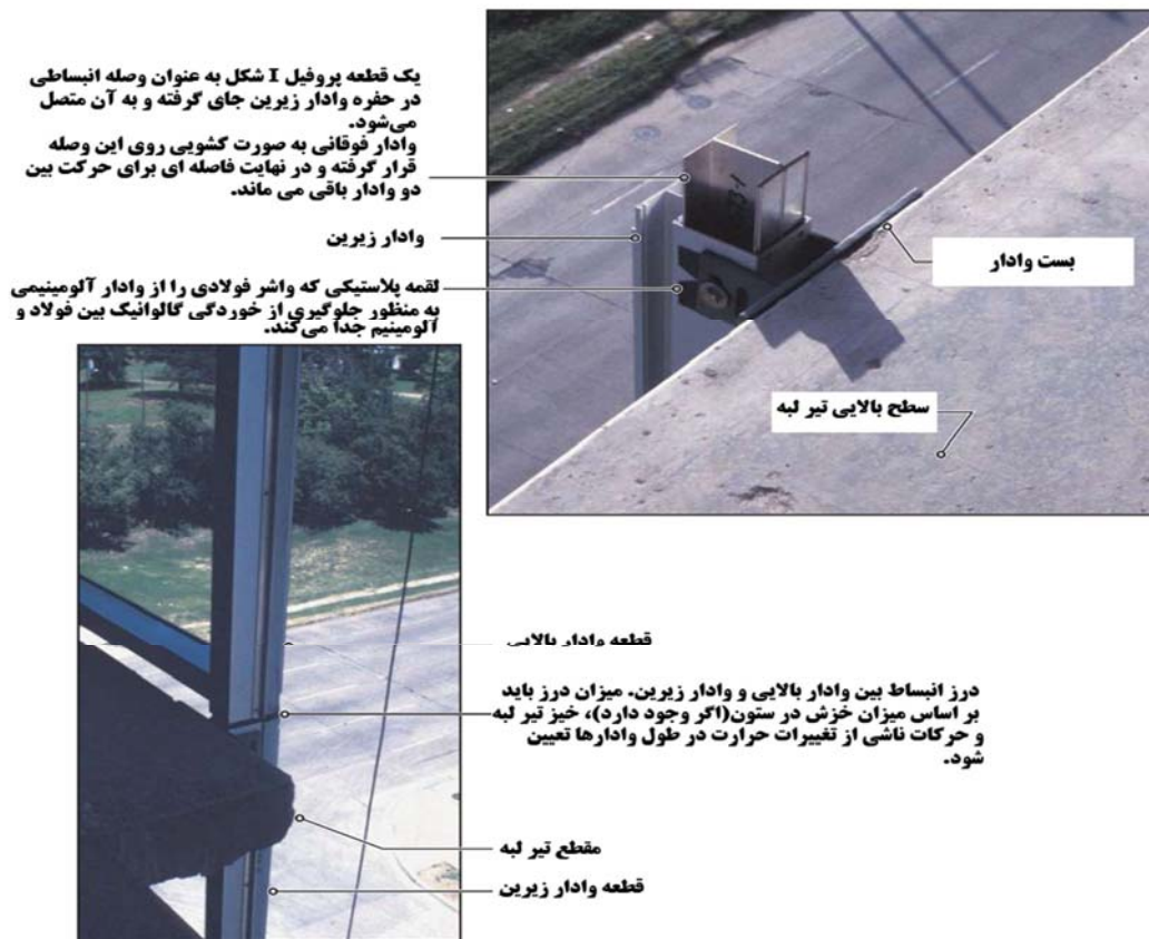
شکل ۸-۸- نمونه اتصال انبساطی بین دو قطعه وادار
