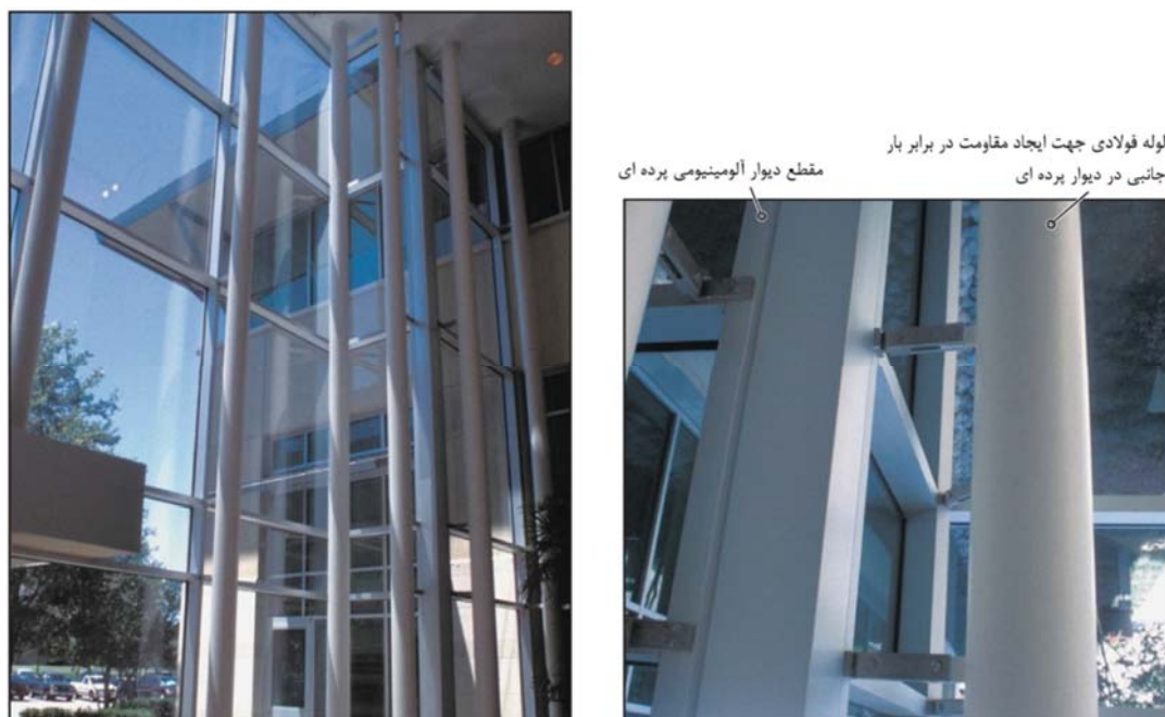
شکل ۸-۱۵- دیوار پرده‌های بلند، جهت تامین مقاومت جانبی به قاب فولادی سازه متصل شده است
