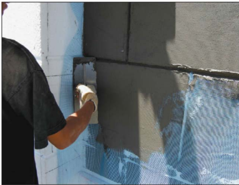
شکل ۶-۱۸- اجرای لایه‌های پوششی
