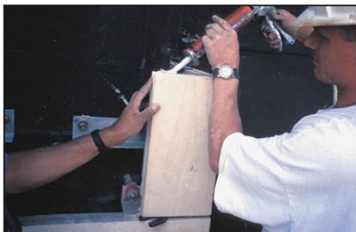
شکل ۴-۱۲- پر کردن شیار موجود در قطعات سنگی قبل از نصب بست‌ها
