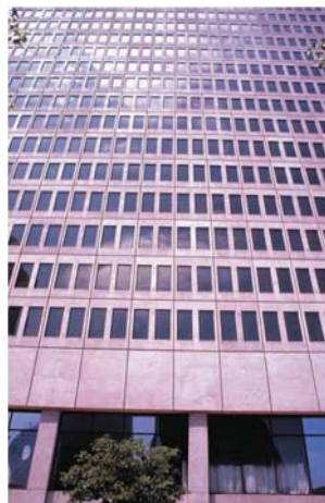
شکل ۶-۲۳- نمای ساختمان ساخته شده با پانل‌های بتنی پیش‌ساخته
