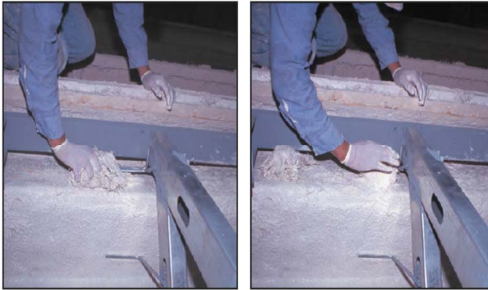
شکل ۶-۴۳- ساختن لایه‌های پیوندی
