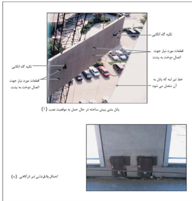
شکل ۶-۳۱- تیپ اتصالات دوخت به پشت که در سه جهت قابل تنظیم می باشند
