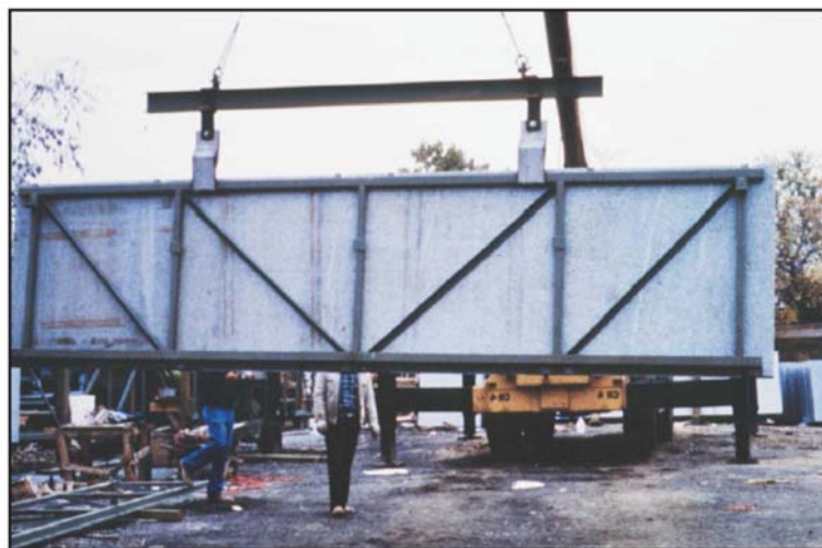
شکل ۴-۲۵- پانل دیواری پرده‌ای پیش‌ساخته سنگی
